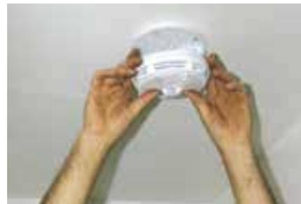
شکل ۱-۱۵ قرار دادن یک نوع آشکارساز روی پایه
