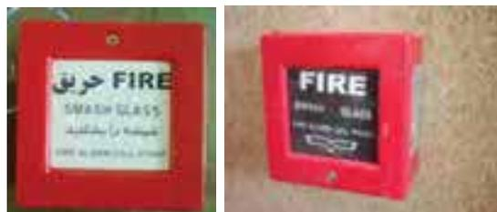
شکل ۱-۲۱ دو نمونه شستی اعلام حریق شیشه‌ای
